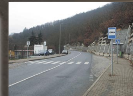
PO ZPEVNĚNÍ SVAHU SE SEM VEŠLA I AUTOBUSOVÁ ZASTÁVKA PRO PŘÍMĚSTSKÉ LINKY 309 A 313.
